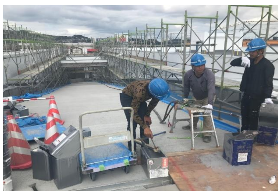
UNなら駐車場もラクラク施工
