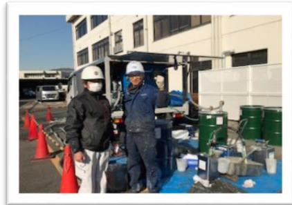
上下水道局第一配水工事事務所・800㎡ ㈱新日本開発様 「2棟も1日で終え助かりました」
